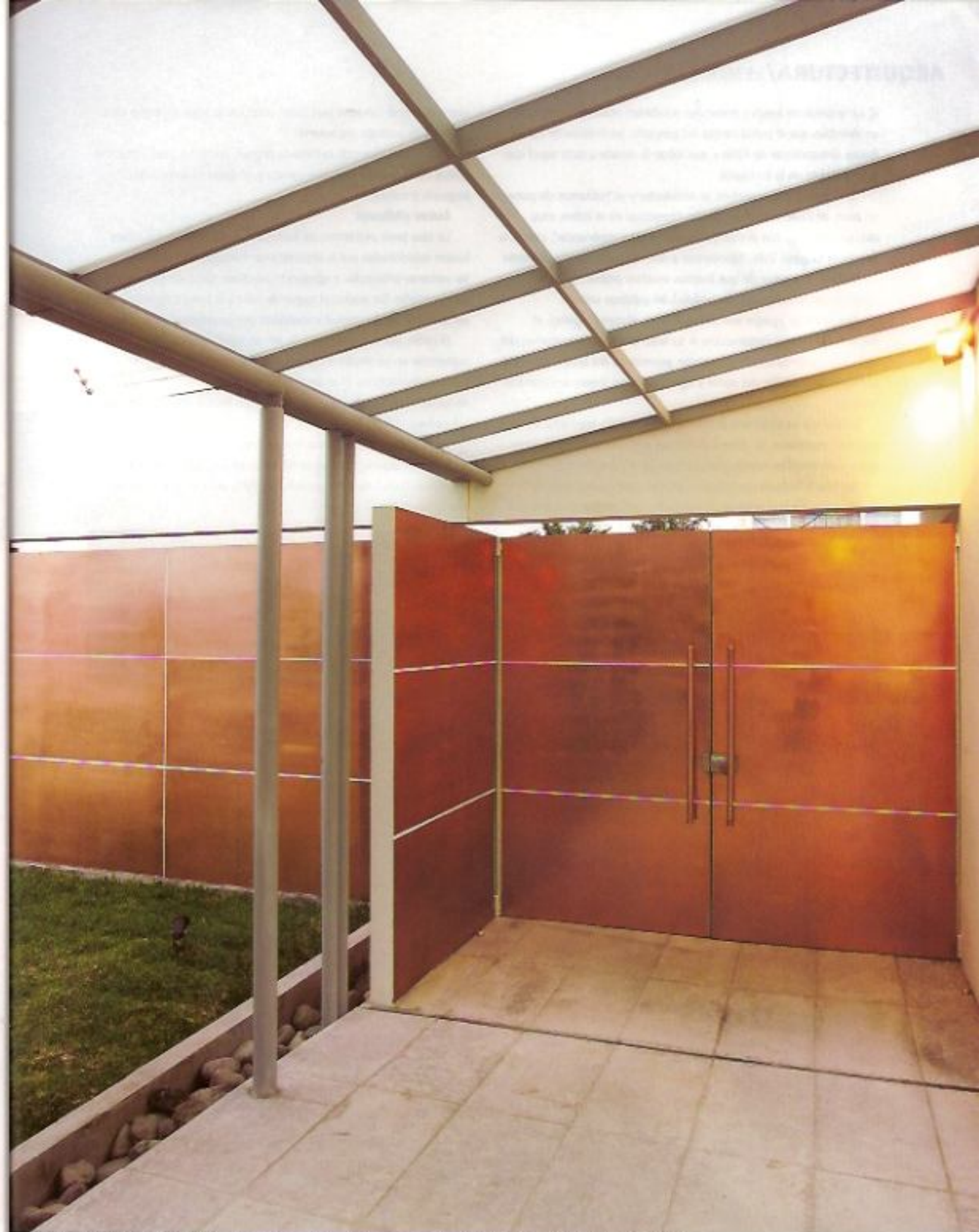
Limpieza completa del jardín y un pequeño caño con piedras de río crean un cauce natural de belleza y simplicidad. Además, los parasoles y el pasillo con techo de policarbonato son ideales para un recorrido en torno al sitio verde de la Embajada.
