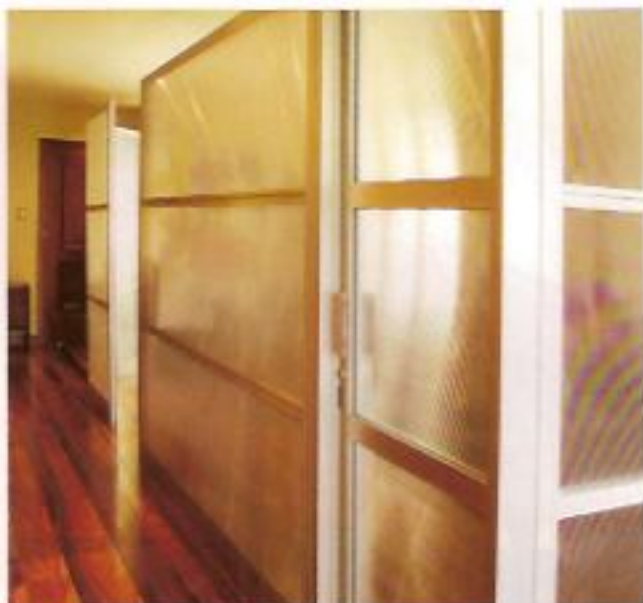
Las divisiones con policarbonato para las distintas oficinas recuerdan el utilizado en la entrada principal y sus mismos propósitos: dejar que la luz fluya. Además, también diluye el aire, dado que la construcción se hizo hasta media altura.
