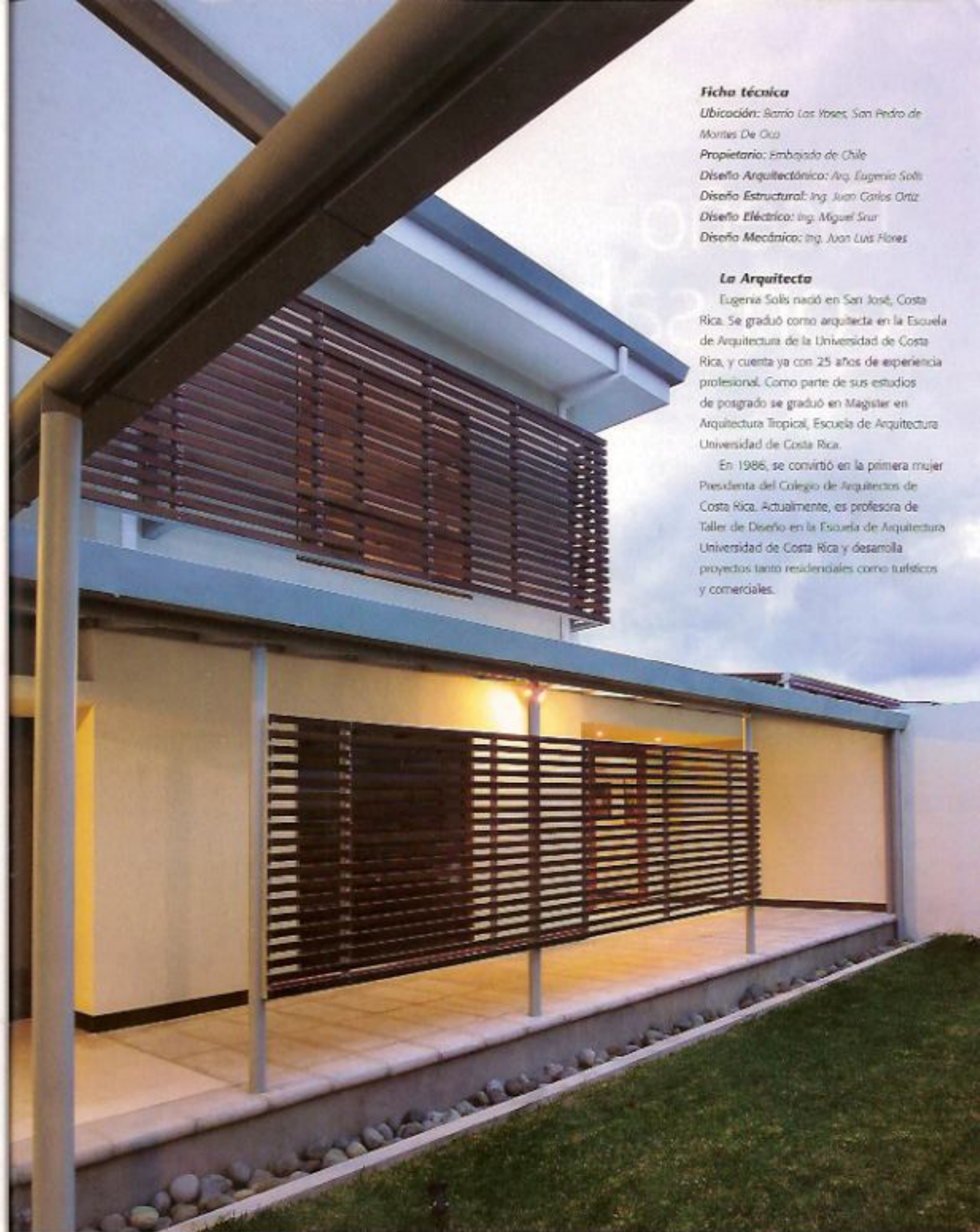
Las dimensiones de las ventanas fueron modificadas para lograr un mejor sistema de ventilación e iluminación interna. Asimismo, se agregaron parasoles que repiten la viveza del cobre y la limpieza de los pisos.
